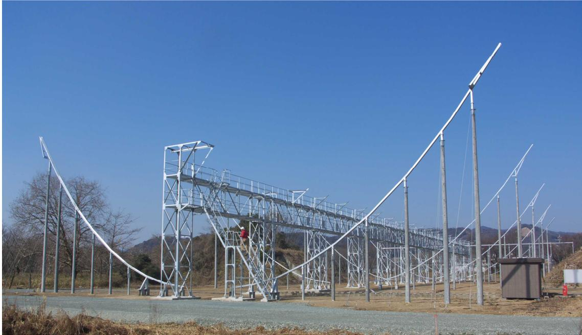
図3. 2007年に完成した南北長10,600cm,東西有効開口幅1895cm×2を有する子午面トランシット型の固定シリンダリカルパラボラアンテナ.パラボラ反射面を支持する構造体にコンクリート柱を使用して経費を節約し限られた予算内でアンテナ開口面積を大きくする.
